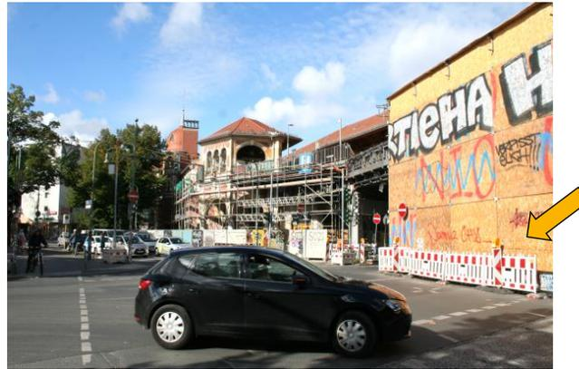
Sie haben die Hochbahn mit **Holzplatten** verkleidet, damit niemand verletzt wird, wenn etwas runterfallen sollte oder wenn geschweißt wird und die Funken fliegen.
